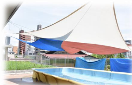
プール（夏期仮設）
